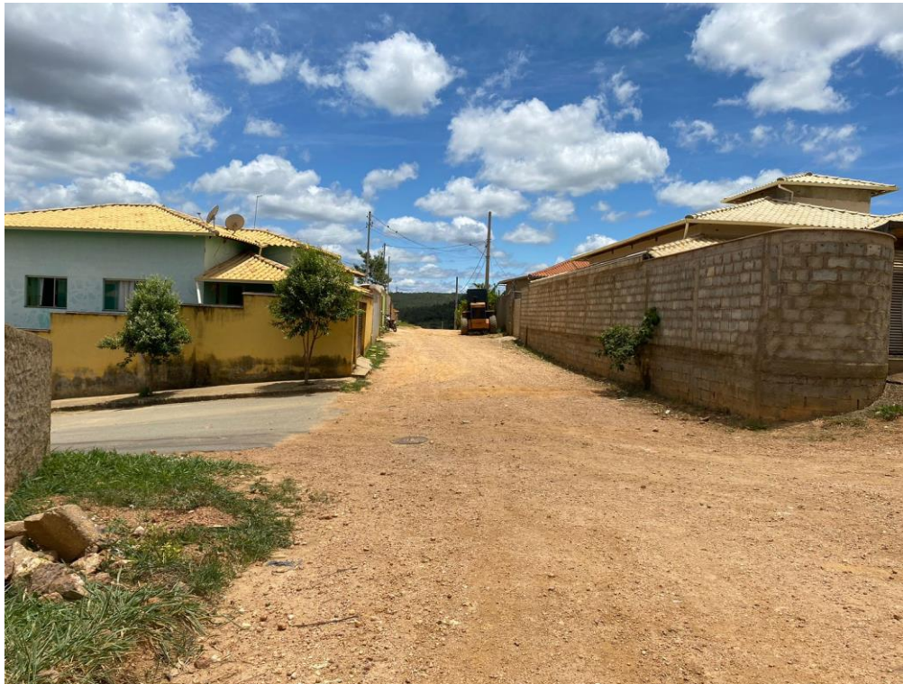
Trecho da Rua Carlos Marques Afonso, esquina com Rua Acácio Marques
